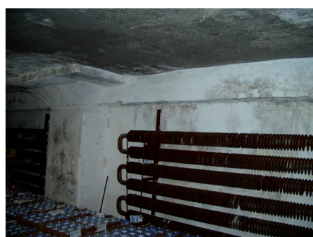
Рис. 1. Фрагмент ограждающих конструкций охлаждаемых помещений до и после нанесения ПУ-покрытия с целью ликвидации грибковой плесени (а) и последствий конденсации влаги (б)
