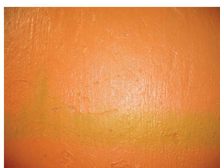
Рис. 1. Фрагмент ограждающих конструкций охлаждаемых помещений до и после нанесения ПУ-покрытия с целью ликвидации грибковой плесени (а) и последствий конденсации влаги (б)
