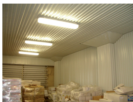
Рис. 1. Фрагмент ограждающих конструкций охлаждаемых помещений до и после нанесения ПУ-покрытия с целью ликвидации грибковой плесени (а) и последствий конденсации влаги (б)
